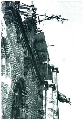
Die Bauhandwerker riskierten manchmal sehr viel. Das Drahtseil des Aufzuges wird wieder an der Rolle befestigt.
