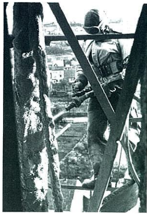
Der Stahl des Turmhelmes ließ sich nicht schweißen. Er wurde mit Bau Stahl umwickelt und mit Beton bespritzt.
