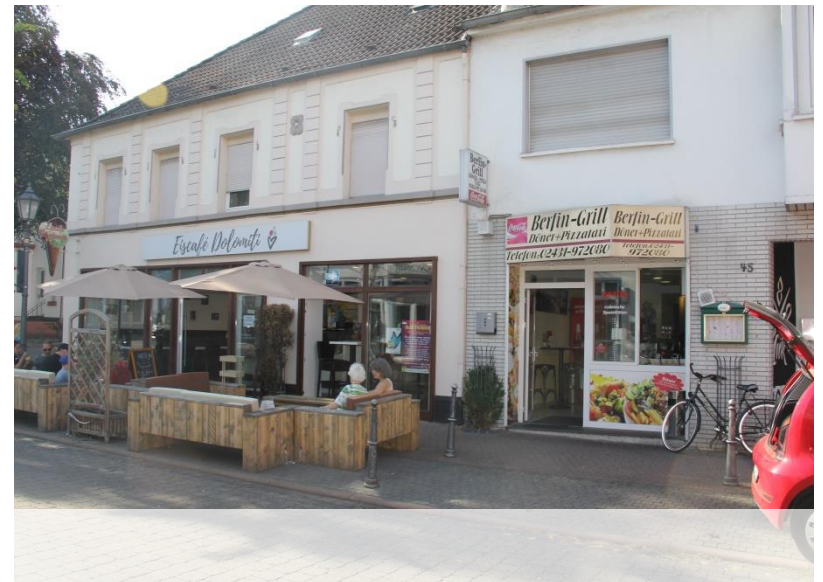
Unattraktive Werbeanlagen / Fassaden
