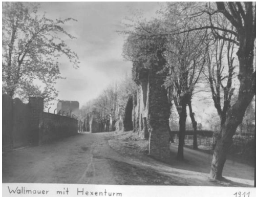
Reste der Stadtmauer um 1911 Quelle: Stadtarchiv Erkelenz (Signatur: F1 1 35)
