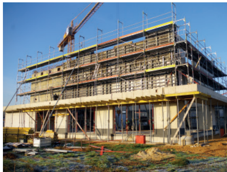
Beim Bau der Mehrzweckhalle Keyenberg (neu) ist die Kostenexplosion spürbar.
