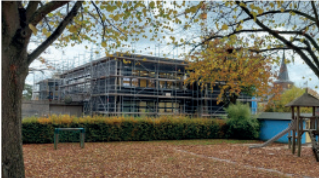
Sanierung der Grundschule in Gerderath
