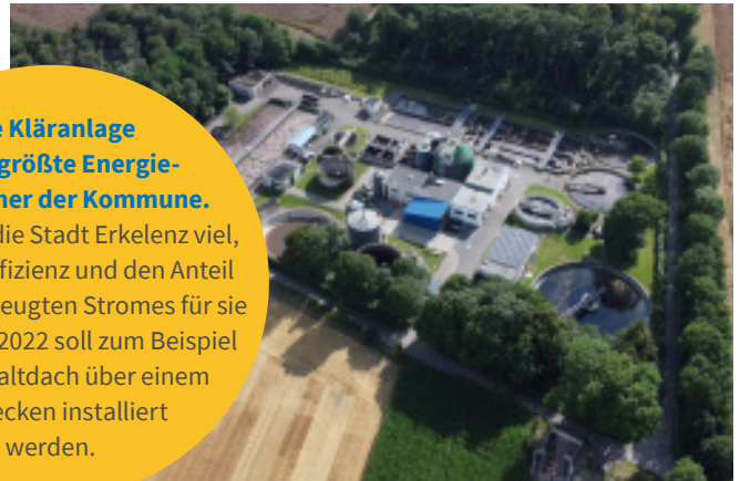
Die Kläranlage am Marienweg ist dank einiger Optimierungen sehr leistungsfähig.
