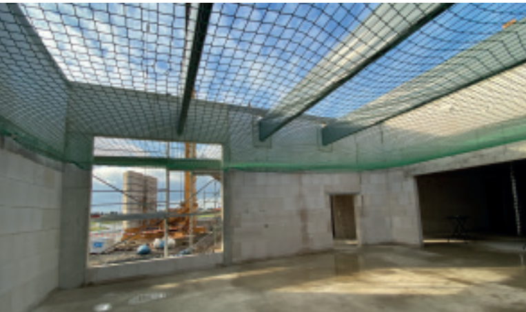
Die positive Finanzlage kommt den Bürger*innen zugute: Hier entsteht eine neue Kita.
