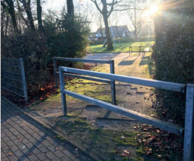
Durch solche Umlaufgitter kommen Rollstühle nur sehr schwer durch.
