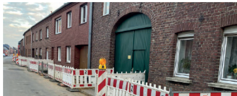
In Holzweiler sind die Arbeiten in vollem Gange.
