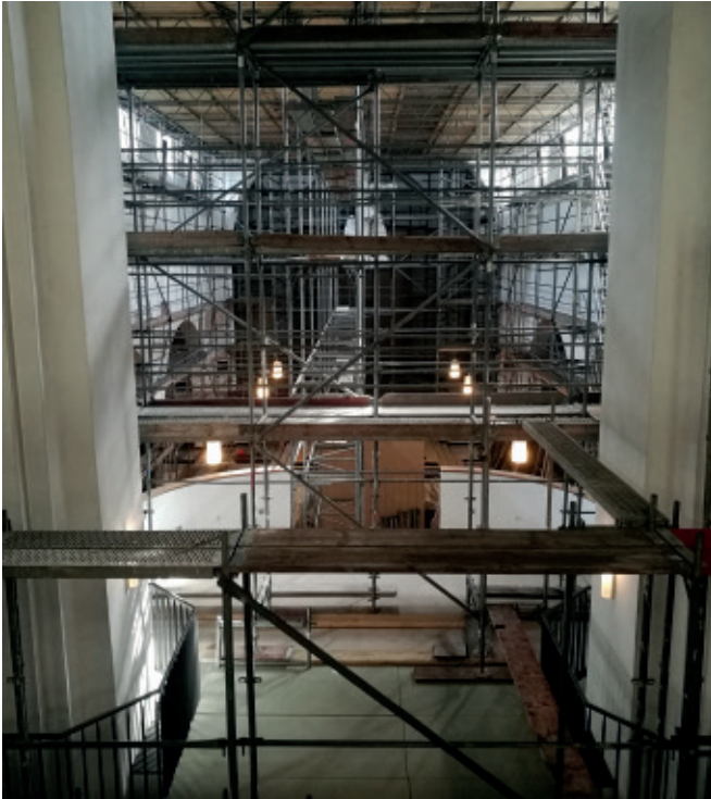
Der Innenraum von St. Lambertus wurde vollständig eingerüstet.
