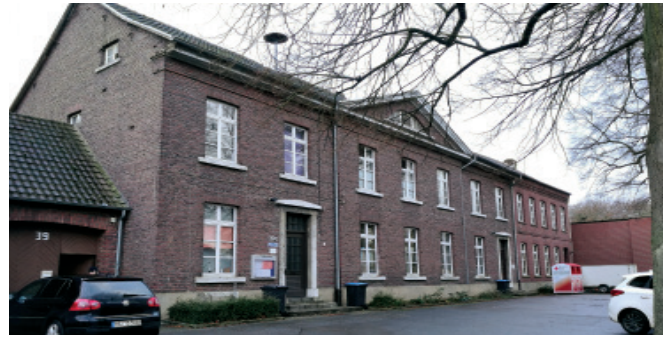
Die ehemalige Schule in Holzweiler wird zum neuen Dorfmittelpunkt umgebaut.
