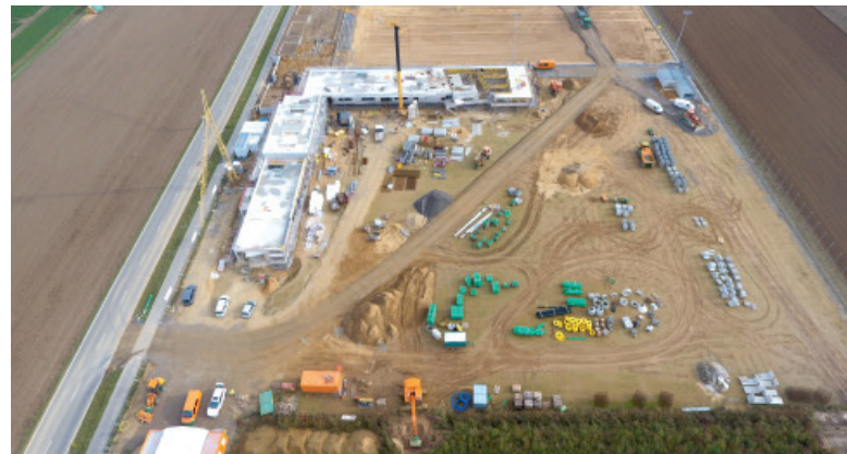
Die Arbeiten an der Sportanlage gehen voran.
