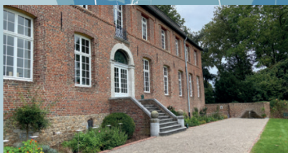
Im Kloster auf Hohenbusch gibt es viel Neues: Kräutergarten, offenes Klassenzimmer, Klosterglocke – für 2022 ist außerdem ein neuer Zugang geplant.
