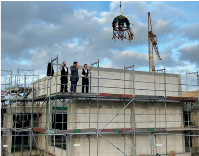
Kita und Quartierszentrum in der Erweiterung des Oerather Mühlenfeldes feierten im Oktober Richtfest.
