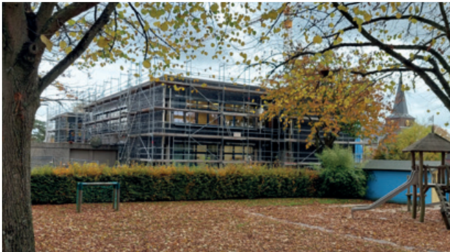
Sanierung der Grundschule in Gerderath
