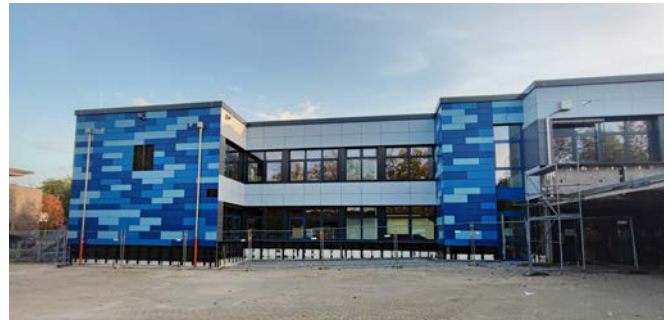
Die Sanierung der Grundschule Gerderath ist fast abgeschlossen.
