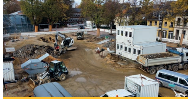
Der Umbau des Franziskanerplatzes schreitet gut voran. Er macht den Anfang für die Neugestaltung der Innenstadt. In diesem Jahr starten auch die Arbeiten an Markt und Grünring an der Wespromenade.
