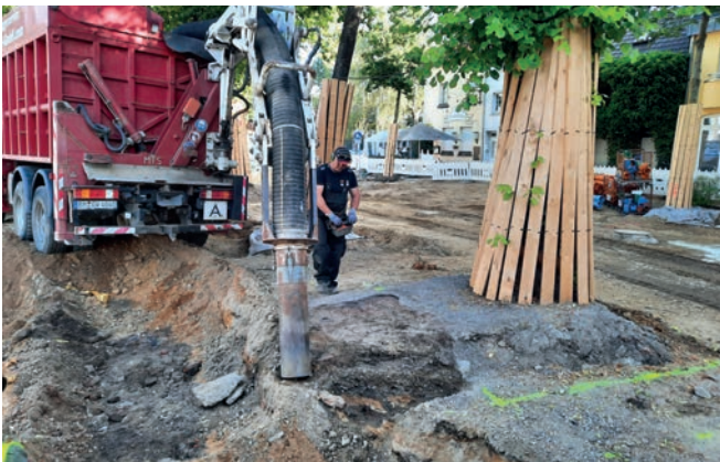
Während der Umbauarbeiten wird das Erdreich rund um die vorhandenen Bäume gelockert und mit Substraten aufgewertet.
