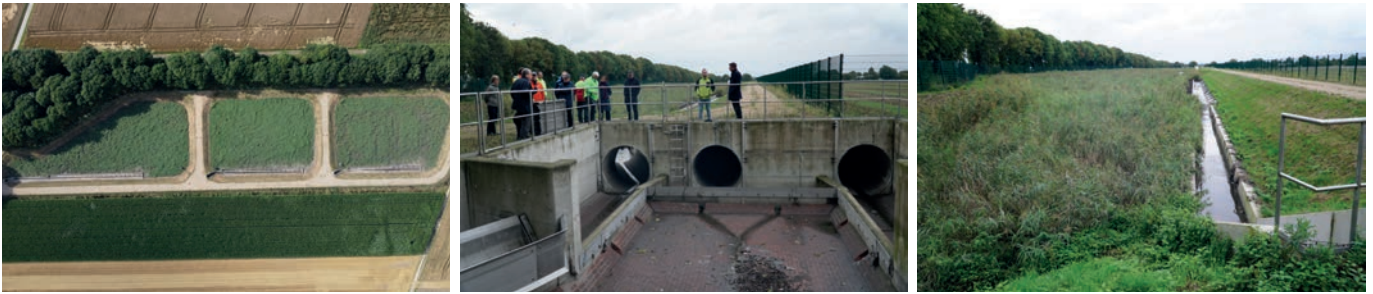
Der Retentionsbodenfilter ist eine große Anlage, die bei starken Regenfällen die Kläranlage unterstützt.
