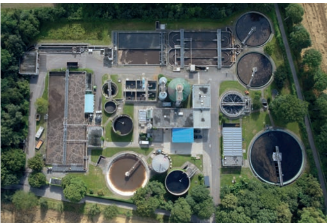
Über dem langen Becken (links) wird das Solarfaltdach Platz finden.
