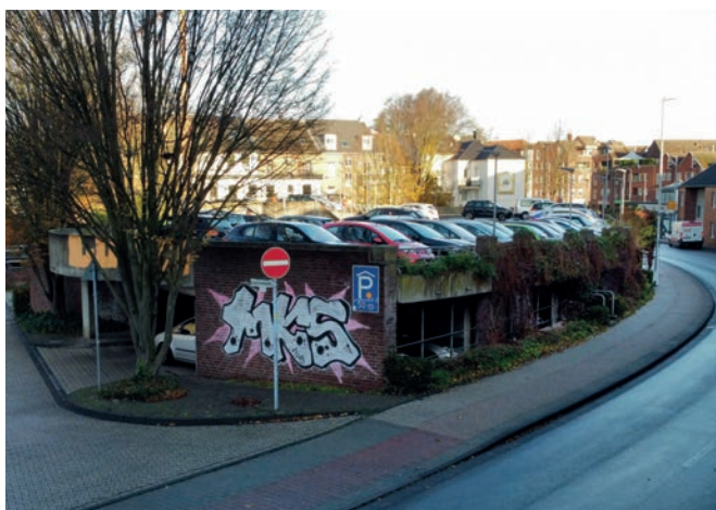
Das alte Parkhaus an der Ostpromenade wird ab 2023 durch einen hochwertigen Neubau ersetzt.
