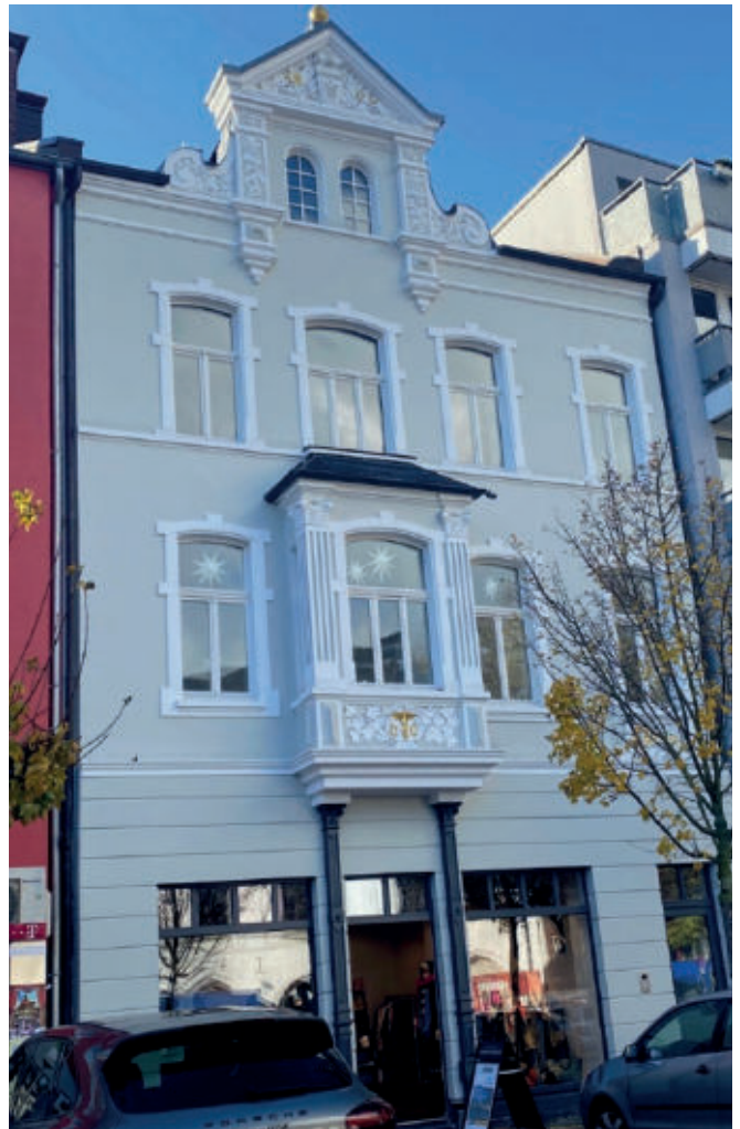
Die Immobilie wurde umgestaltet und die Fassade erneuert, FUNK zog in das Ladenlokal ein.
