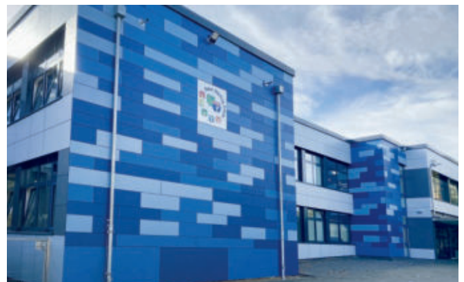
Die energetische Sanierung der Peter Härtling Schule in Gerderath wurde 2023 abgeschlossen.
