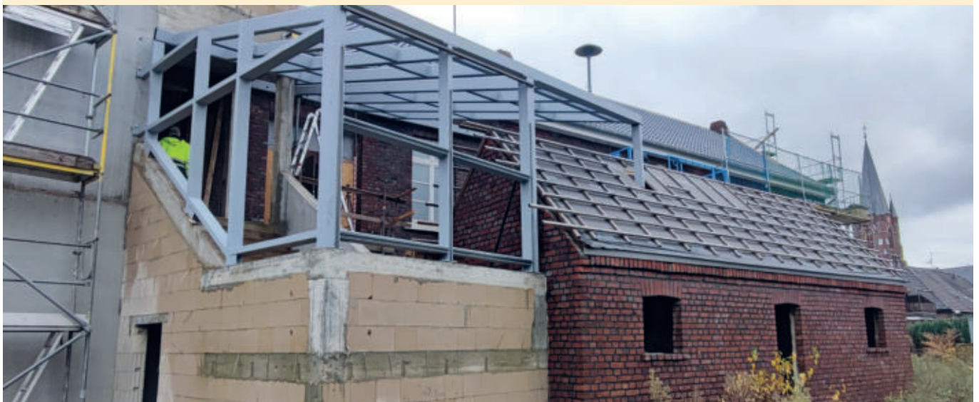
Umbau alte Schule Holzweiler: Die Abstellräume werden durch einen Anbau mit der Schule verbunden.
