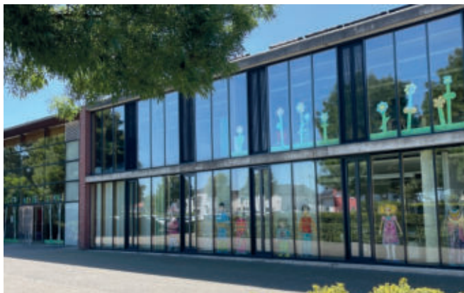
Die Luise-Hensel-Schule liegt im Norden der Schulstadt Erkelenz und wurde im Herbst 2001 bezogen.
