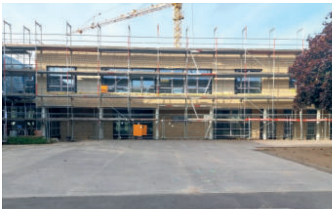
Die Gemeinschaftsgrundschule in Kückhoven erhält einen zweigeschossigen Neubau.
