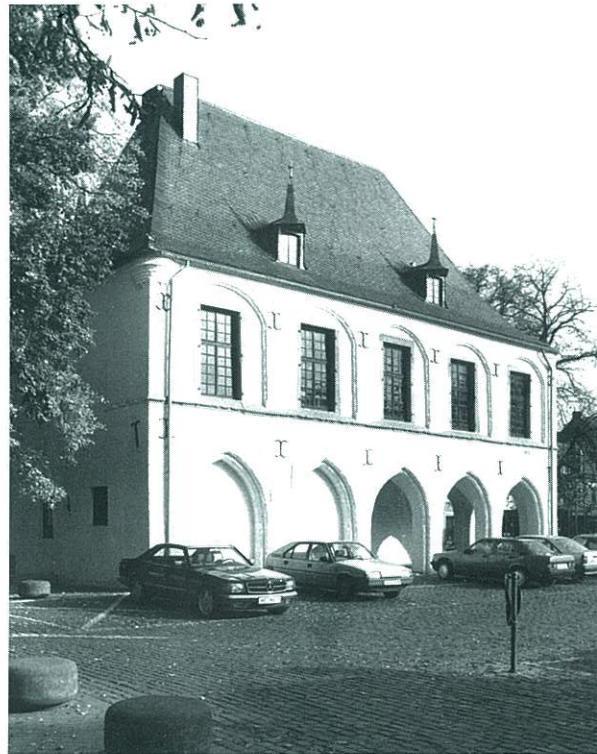
Die Westseite des Alten Rathauses.
