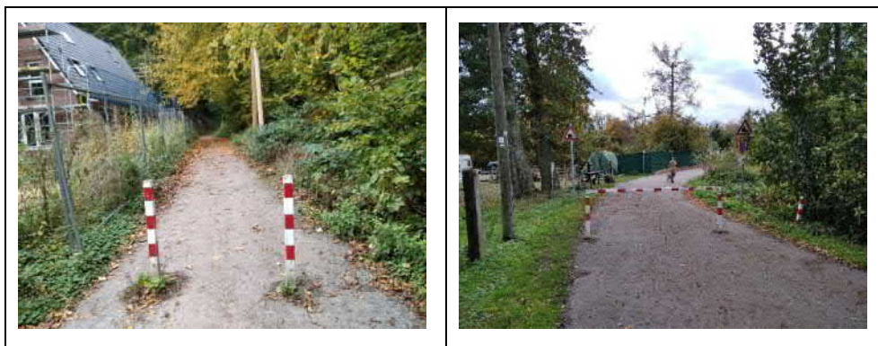
Bild 30: Anwendungsbeispiele für Poller (links) und Umlaufsperrern in Ratingen (rechts) (Quelle: eigene Aufnahme)
