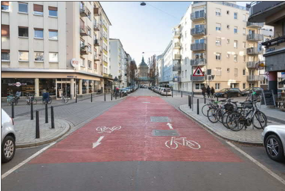
Bild 40: Gestaltung eines Knotenpunktes einer Fahrradstraße (Quelle: eigene Aufnahme)
