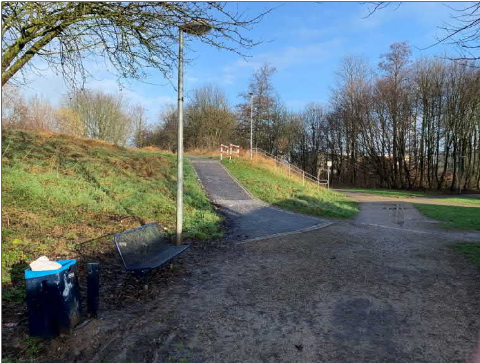
Bild 72: Rampe für den Radverkehr am KP Nördliche Brücke über B 57 ins Oerather Mühlenfeld (Quelle: eigene Aufnahme)
