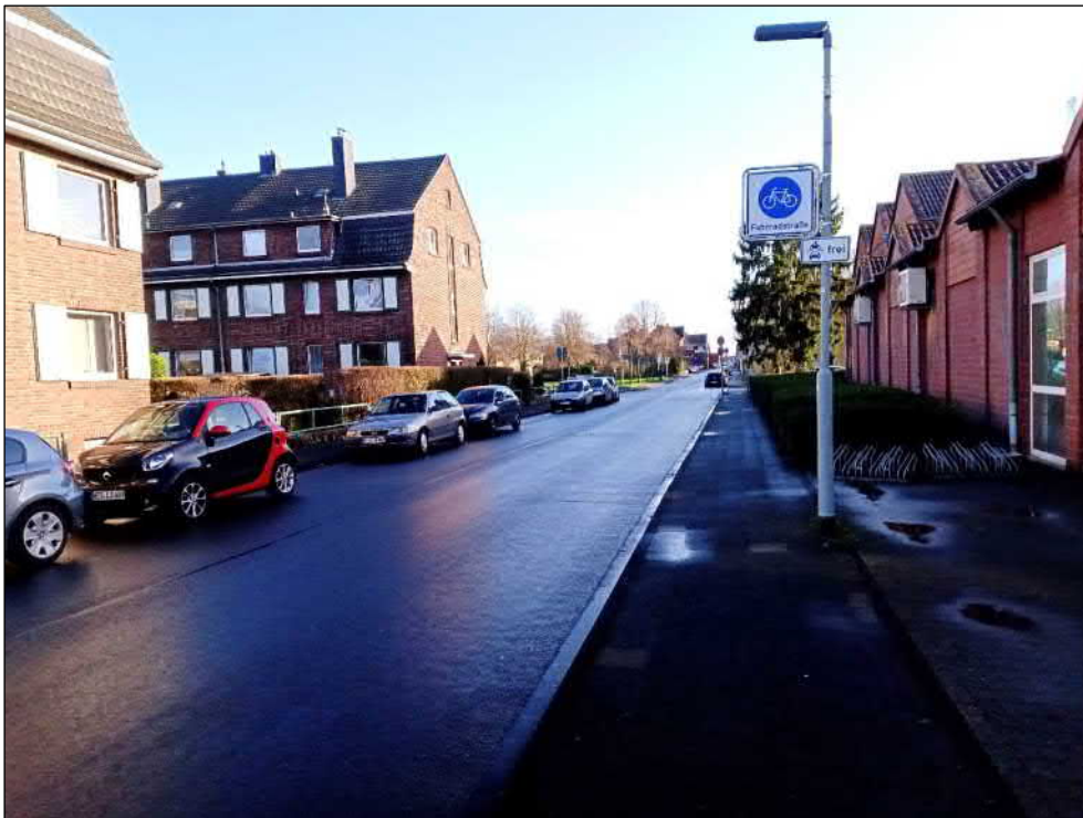
Bild 42: Negativbeispiel mit fehlenden Sicherheitstrennstreifen in einer Fahrradstraße (Quelle: eigene Aufnahme)
