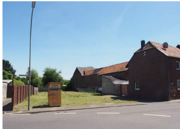
Fehlende Raumkante, Kofferer Straße Ecke Titzer Straße, Foto RaumPlan.
