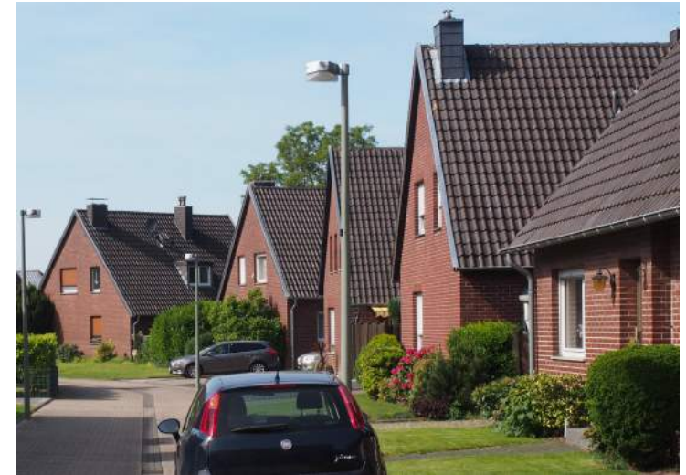
Gebäude aus den Jahren 1950 bis 1960, Im Kamp, Foto RaumPlan.
