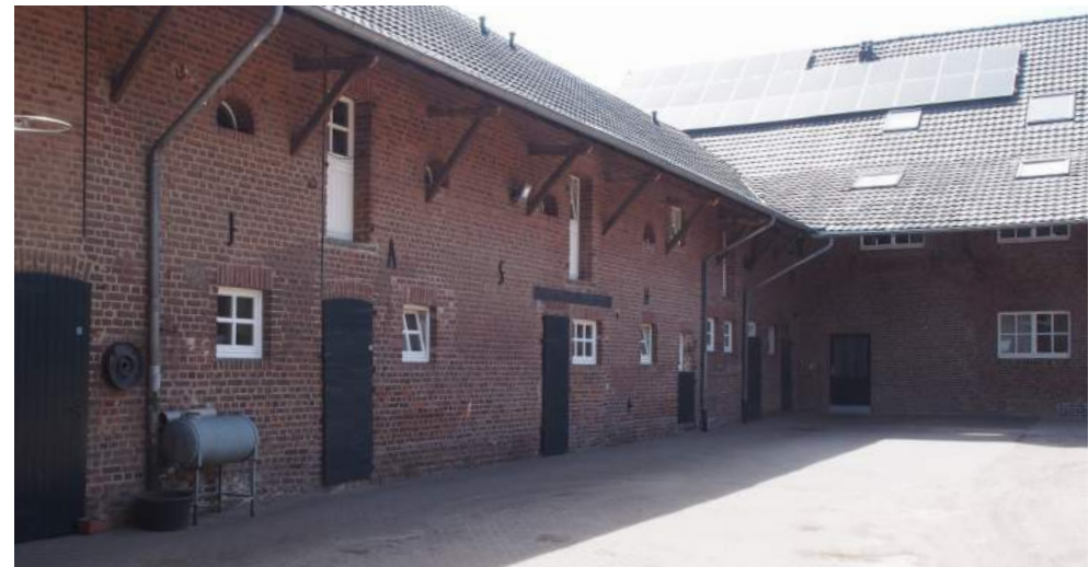
Umgebaute Hofanlage Titzer Straße 4, Foto RaumPlan.
