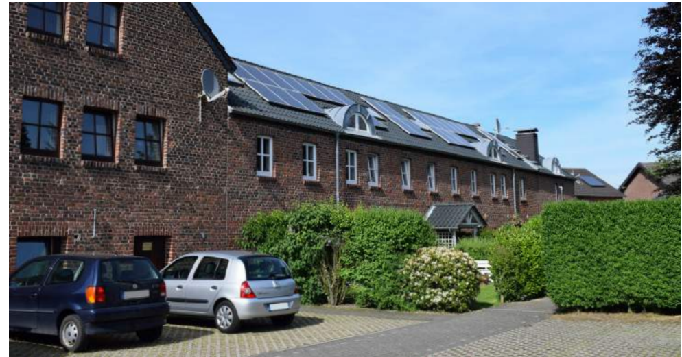
Umgebaute Hofanlage Titzer Straße 4, Foto RaumPlan.
