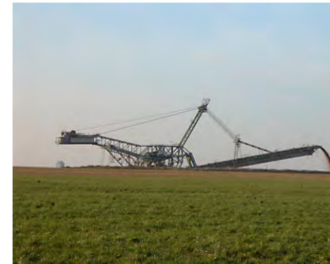
Tagebau Garzweiler, Foto webwrite, Zugriff 10.08.2017.
