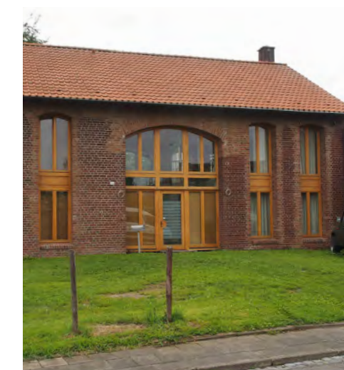
Gebäude in gutem Zustand in Kaulhausen, Foto RaumPlan.
