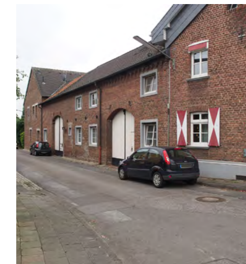
Historische Hofanlage in Kaulhausen, Foto RaumPlan.
