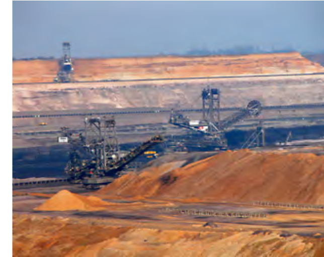
Tagebau Garzweiler, Foto webwrite, Zugriff 10.08.2017.
