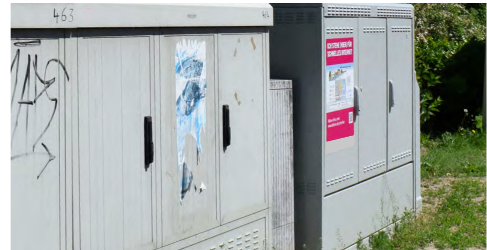
Breitbandausbau im benachbarten Holzweiler, Foto RaumPlan.
