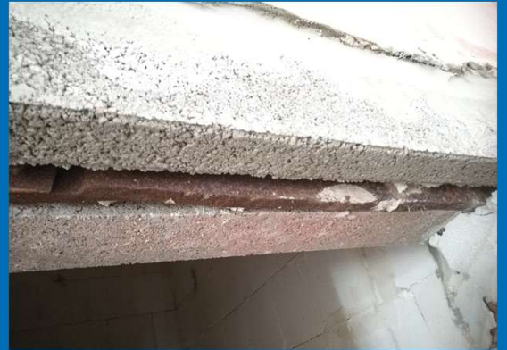
Historischer Zuganker über Aufzugszugang
