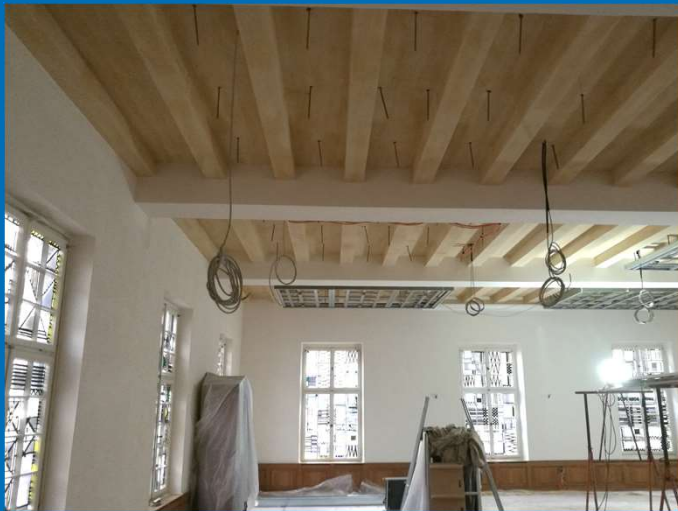
Nach Rückbau wiederentdeckte Rabitzdecke von 1956
