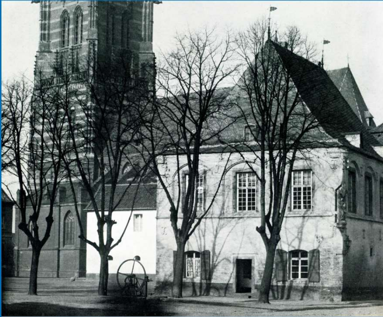
Historischer Zustand mit geschlossenen Arkaden
