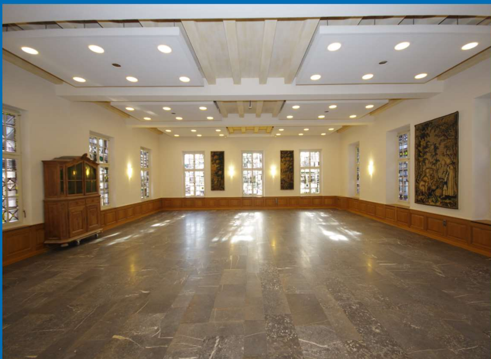
Nach Rückbau wiederentdeckte Rabitzdecke von 1956
