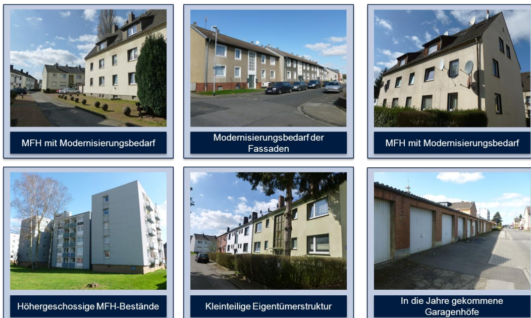
Abbildung 65: Nebeneinander von modernisierungsbedürftigen Mehrfamilienhäusern...
