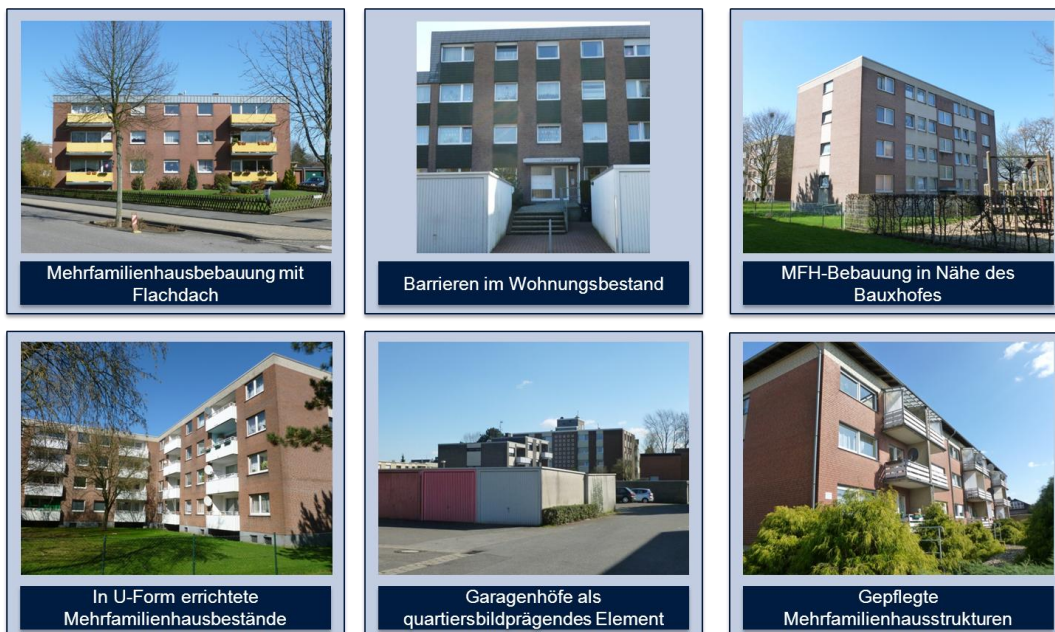
Abbildung 57: Starke Prägung des Quartiers „Schulring“ durch MFH-Bebauung der 1970er Jahre
