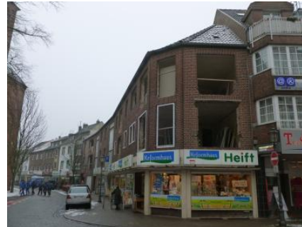
Kernsanierung eines MFH in der Erkelenzer Innenstadt
