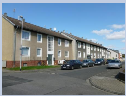
Modernisierungsbedarf der Fassaden
