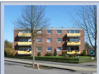
Mehrfamilienhausbebauung mit Flachdach
