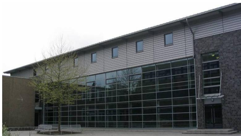
Zur Schulhofseite ist die Flurzone mit einer transparenten Fassade über zwei Geschosse ausgebildet, die als Wärme- bzw. Kältepuffer dient. Den oberen Abschluss bildet ein zum Schulhof abfallendes Pultdach mit Kalzip-Eindeckung. Die 16 Klassen sind allesamt zum Norden, abseits des Schulhofes, ausgerichtet. Hierdurch bedingt wurde auf den Sonnenschutz innerhalb der Klassen verzichtet.
